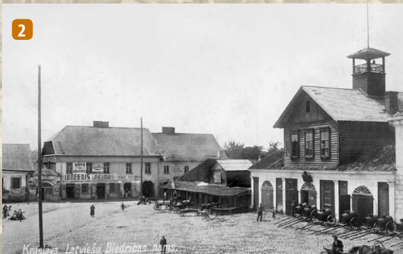
Kraslava. Latviesu Biedrības nams.
